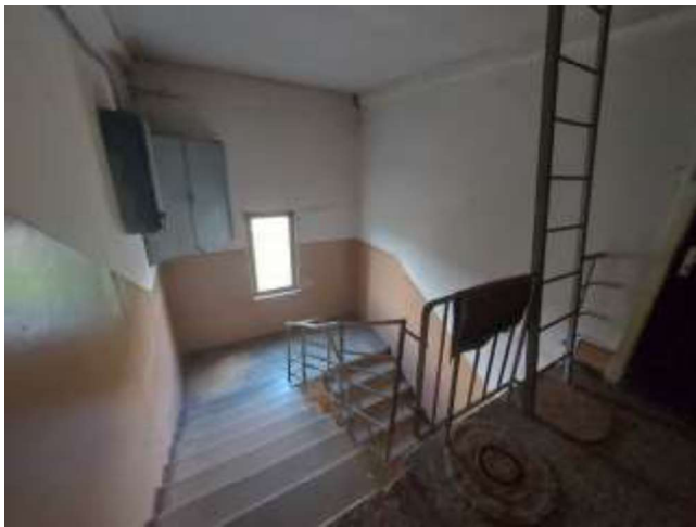
3.stāva kāpņu telpa
